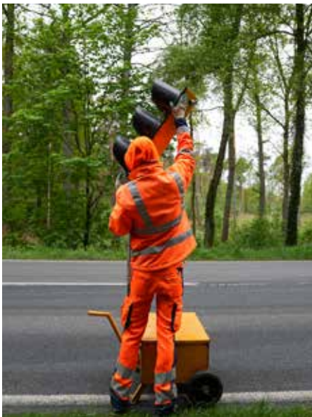
FERTIG ABGESICHERT: Nach der Beschilderung wird die Ampel aufgestellt.
