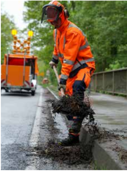
REINIGUNG MIT SCHAUFEL UND BESEN: Die Reinigung der Gassen und Abläufe erfolgt in Handarbeit.
