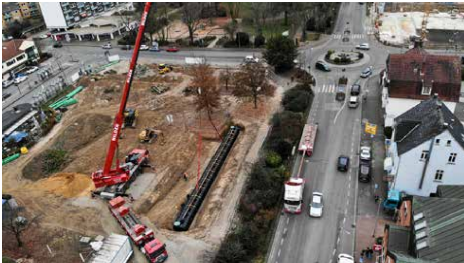
Das Projekt kooperiert mit einer Wohnungsbaugesellschaft, in deren Quartier es verwirklicht wird.
