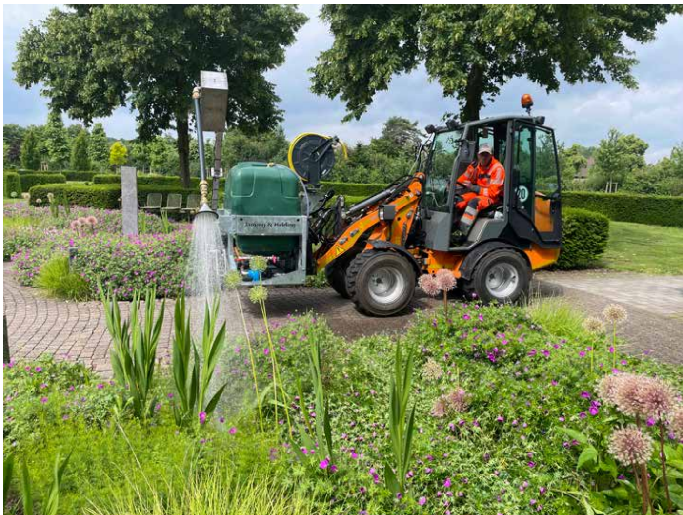
Fotos: Werkbild, Baubetriebshof Ahaus
