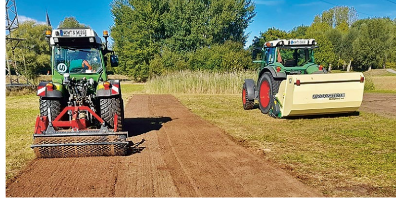
Fachgerechte Bodenvorbereitung bei der Neuanlage einer Blühwiese.
