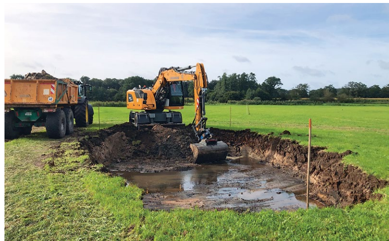
Baggerarbeiten zur Neuanlage einer Senke.
