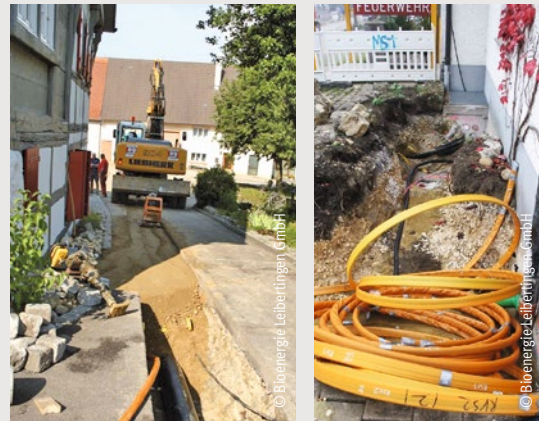
Abbildung 3.7: Verlegung von Glasfaserleitungen
