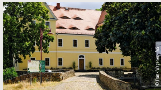
Abbildung 5.32: Das Nahwärmenetz in Röcknitz bindet in einem ersten Bauabschnitt eine Vielzahl öffentlicher Gebäude ein.
