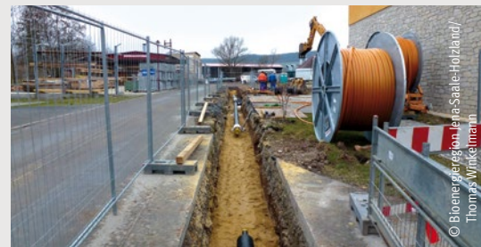
Abbildung 3.8: Verlegung von Glasfaser- und Nahwärmeleitungen im Bioenergiedorf Schlöben
