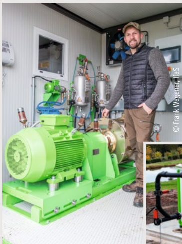
Abbildung 5.10: Zur Erhöhung der Fließfähigkeit und Verringerung der Verweildauer nutzt René Blum eine Aufbereitungsanlage. Die schwer abbaubaren Fasern schwimmen in der Regel oben im Fermenter. Das dortige Gärsubstrat wird über ein Rohr der Aufbereitungsanlage zugeführt. Durch einen Druckwechsel in der Aufbereitungsanlage (Kavitation) werden Fasern und Zellwände des Substrats zerkleinert bzw. zerstört und so die Vergärbarkeit des Materials um 10 bis maximal 15 % verbessert.
