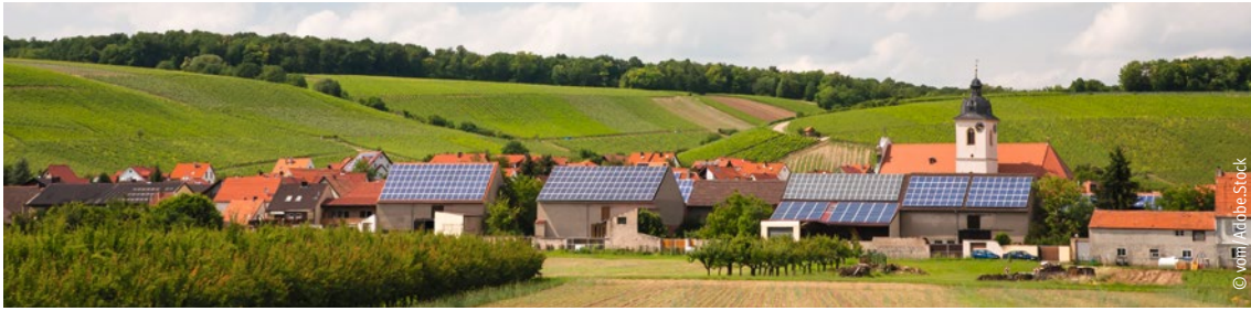
Abbildung 4.7: PV-Anlagen auf Wirtschaftsgebäuden
