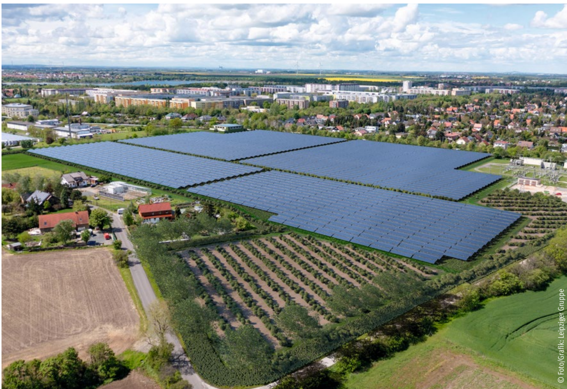
Abbildung 4.11: Die Solarthermie-Anlage Leipzig-West entsteht in unmittelbarer Nachbarschaft zu einem Biomasse-Heizkraftwerk.
