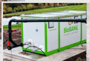
Abbildung 5.10: Zur Erhöhung der Fließfähigkeit und Verringerung der Verweildauer nutzt René Blum eine Aufbereitungsanlage. Die schwer abbaubaren Fasern schwimmen in der Regel oben im Fermenter. Das dortige Gärsubstrat wird über ein Rohr der Aufbereitungsanlage zugeführt. Durch einen Druckwechsel in der Aufbereitungsanlage (Kavitation) werden Fasern und Zellwände des Substrats zerkleinert bzw. zerstört und so die Vergärbarkeit des Materials um 10 bis maximal 15 % verbessert.
