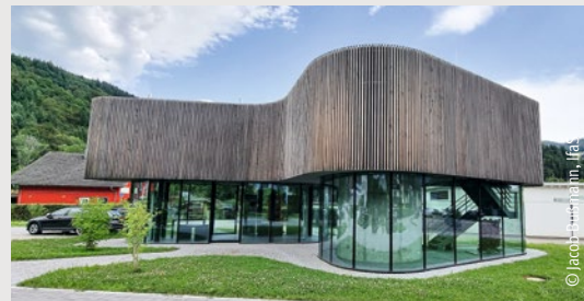
Abbildung 7.21: Heizzentrale mit Ausstellungsraum am Freibad in Schönau
