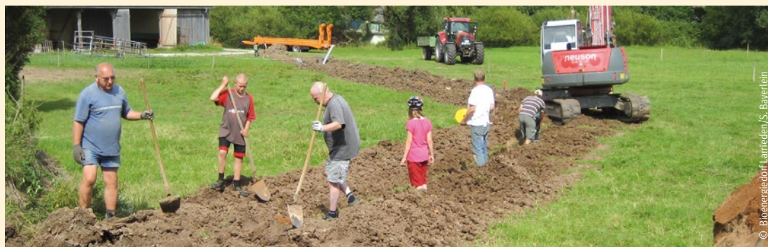
Abbildung 3.16: Verlegung von Nahwärmeleitungen durch Bürger im Bioenergiedorf Larrieden
