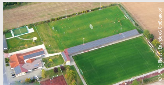
Abbildung 3.22: Die Bürger-PV-Freiflächenanlage und die Bürger-PV-Tribünenanlage im Bioenergiedorf Großbardorf
