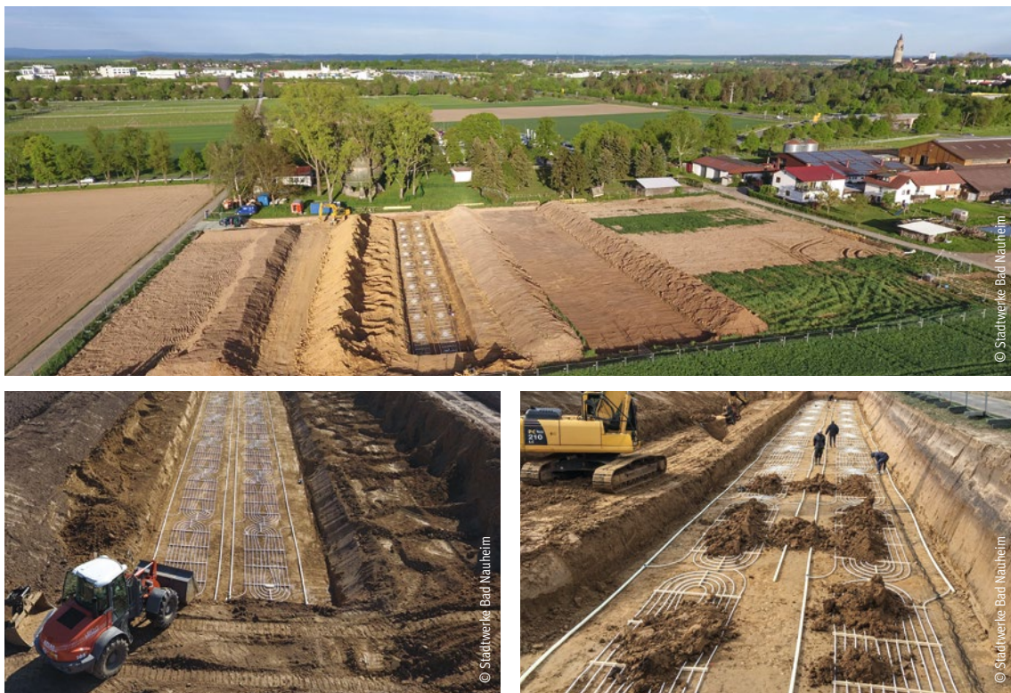
Abbildung 4.14: Deutschlands größter Erdkollektor der Stadtwerke Bad Nauheim GmbH mit 22.400\text{ m}^2
