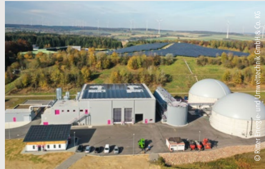
Abbildung 2.3: Standort der Rhein-Hunsrück Entsorgung mit Biomassevergärungsanlage (unteres Bild), PV-Freiflächenanlage auf dem ehemaligen Deponiekörper (im Hintergrund) und Heizzentrale mit Solarthermie-Anlage (oberes Bild)
