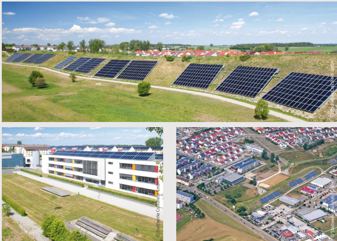
Abbildung 4.12: Solarthermische Kollektoren auf einem Lärmschutzwall speisen in das Nahwärmenetz Crailsheim Hirtenwiesen ein.
