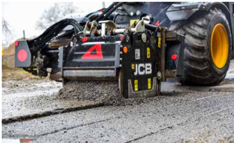
Auf 600 mm Breite kann der Hydradig PotholePro den Asphalt bis zu 170 mm tief in einem Durchgang wegfräsen.
