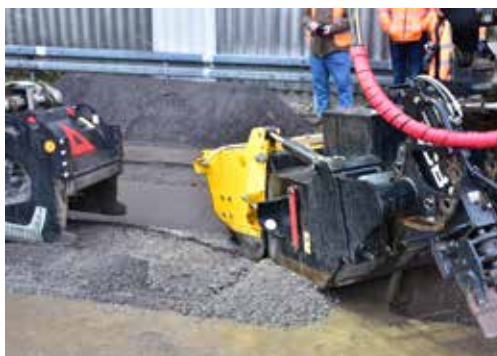
Im Anschluss wird die Baustelle mit der Kehrmachine gereinigt. Der Sammelbehälter bietet auch eine Schaufelfunktion.
