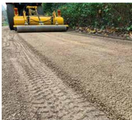
**oben:** Im gleichen Arbeitsgang mit der Materialverteilung drückt die Walze die Deckschicht (rechts im Bild) final an. Links die zuvor aufgebraute und egalisierte Altschicht.
