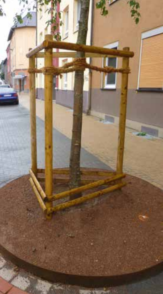
In Bochum wird das sogenannte Stockholmer Modell getestet, das überschüssiges Wasser über Rigolen und grobporiges Pflanzsubstrat besser für Bäume nutzbar machen soll.
