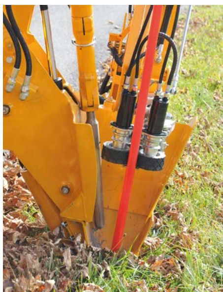
Die Schneestange wird im vorbereiteten Bohrloch platziert
