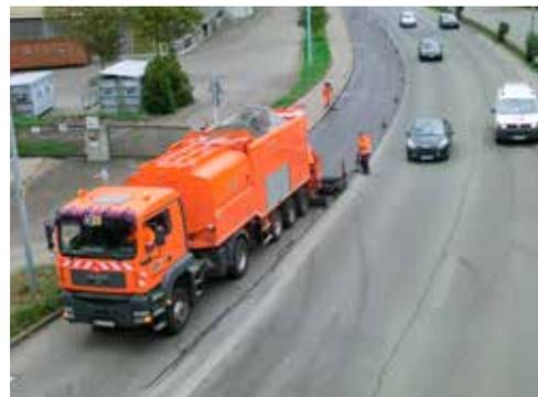
Da im System ein äußerst geringer, konstanter Spritzdruck vorherrscht, lassen sich die Vorspritzarbeiten bei minimaler Vernebelung und Verschmutzung durchführen.
