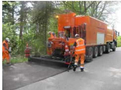
Der VSI Dünnschichtasphalt ist kurzfristig und schnell einzubauen und beeinträchtigt den fließenden Verkehr kaum.
