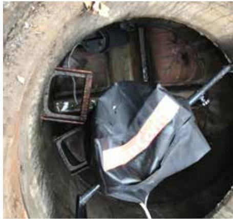
In Berlin wurde an einigen Stellen die Smart Trap installiert. Das „Rohr“ unten tötet die Ratten ähnlich einer Schlagfalle. Auf dem Gerät oben können die Auslösungen abgelesen werden.
