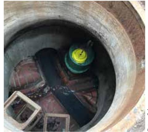
Die Köderschutzbox B-Ball wird derzeit in Berlin getestet. Bei steigendem Wasserpegel verschließt sie sich, damit kein Gift ins Wasser gelangt.
