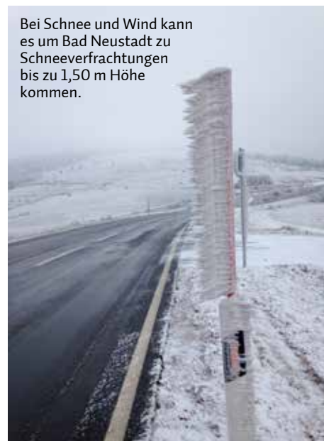
Das technische Bauamt Rhön-Grabfeld ist für 335 km Kreisstraßen und circa 25 km Orts- und Gemeindeverbindungsstraßen verantwortlich.
