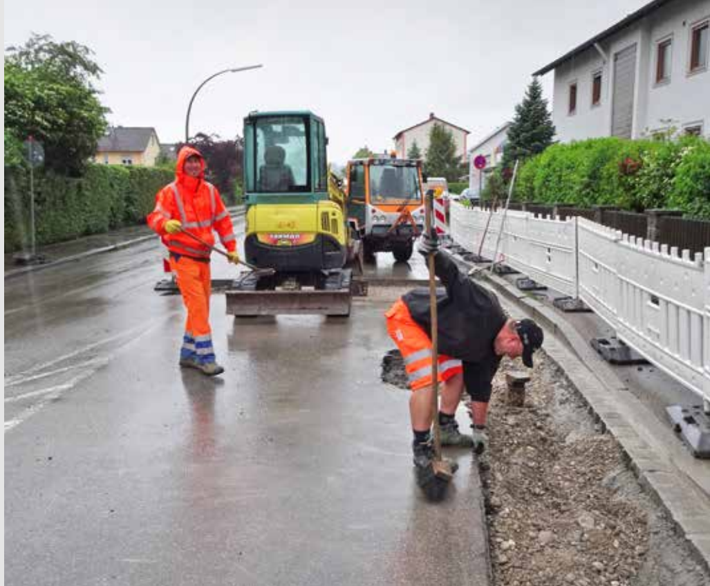
V.l.: Straßenbauer Heiko Gobig und Ralf Klein beim Setzen einer Wasserführungsrinne
