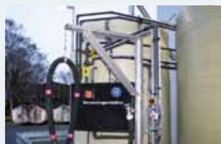
Soleerzeuger für NaCl-, MaCl-, und CaCl-Sole mit 20–22 % Sättigung ...
