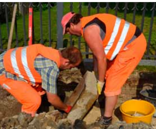
Absenkungen von Rohrleitungen und Sinkkästen sind im Donaumoos an der Tagesordnung. Kleines Bild: Jürgen Thaller (links) und Tobias Schwinger setzen den neuen Gully in den Beton.
