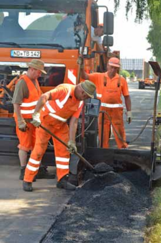
Bei schmalen Fräsflächen kommt der selbst entwickelte und gebaute Asphaltzieher zum Einsatz.
