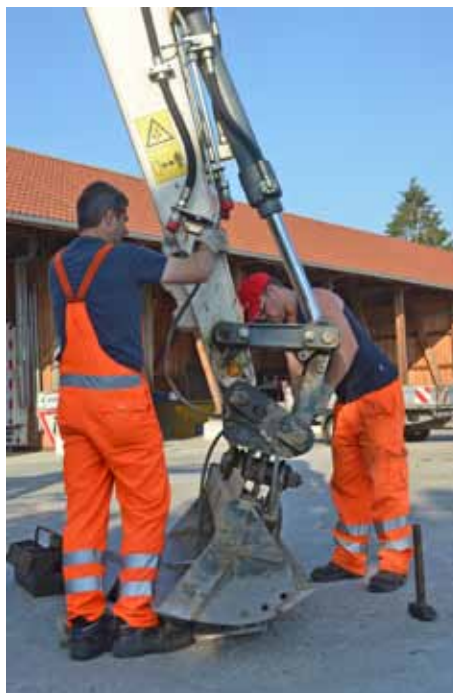
Morgens wird zügig angerüstet und Material verladen, um den halbwegs kühlen Vormittag zu nutzen. Denn die Wetterfrösche haben 34 Grad angekündigt...
