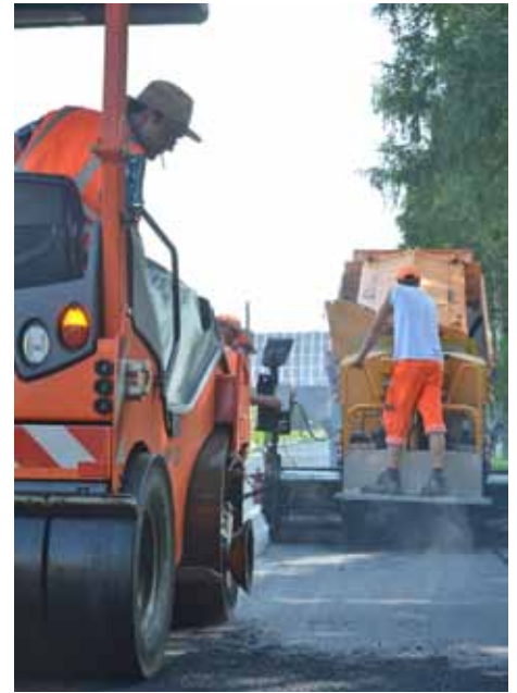
Ein eingespieltes Team: Gleich nach dem Fertiger folgt die Walze.
