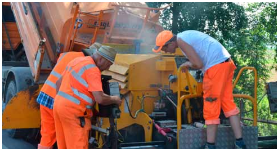
An jeder Frässtelle muss neu justiert und eingestellt werden, um die optimale Einbaustärke der Asphalt-schicht zu erreichen.
