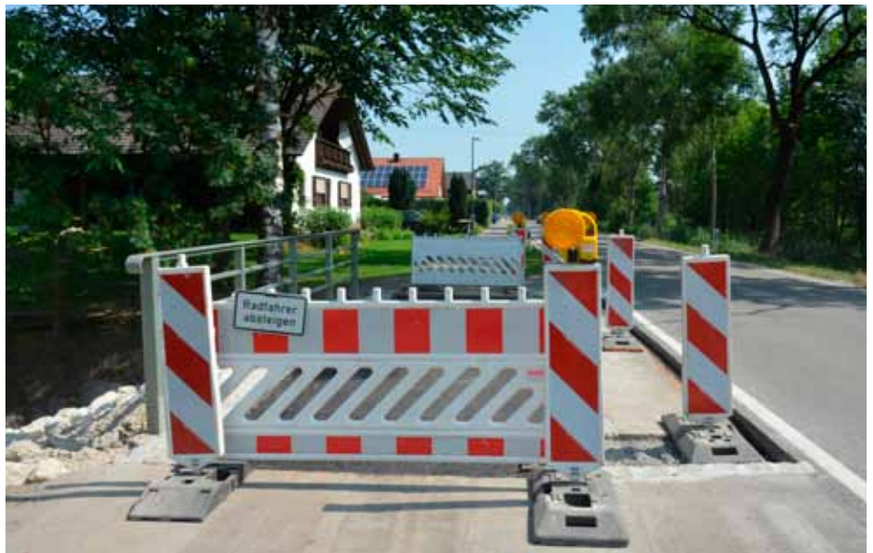
Auch Brückensanierungen gehören zum Alltag des Tiefbauamtes. Allein bei Betonbrücken hat der Landkreis rund 50 Stück zu betreuen.
