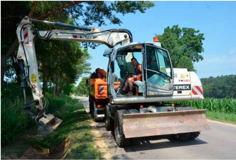
Zu den Tagesaufgaben während der Tour durch den Landkreis gehörte auch die Grabenreinigung.
