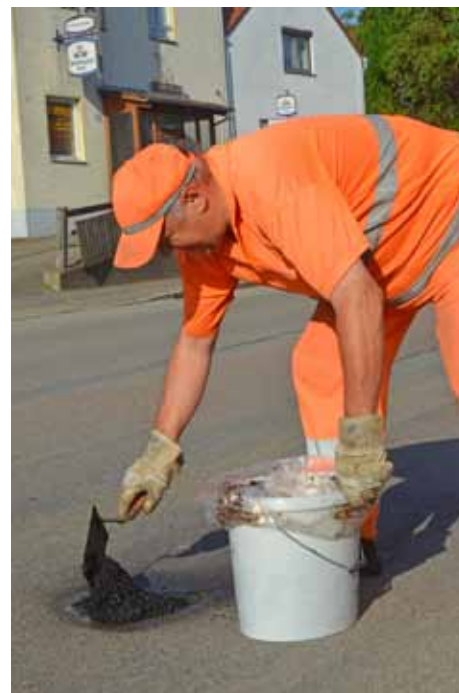
Während seiner Kontrolltour bessert Josef Dannenhauer kleinere Straßenschäden gleich mit Kaltasphalt aus.
