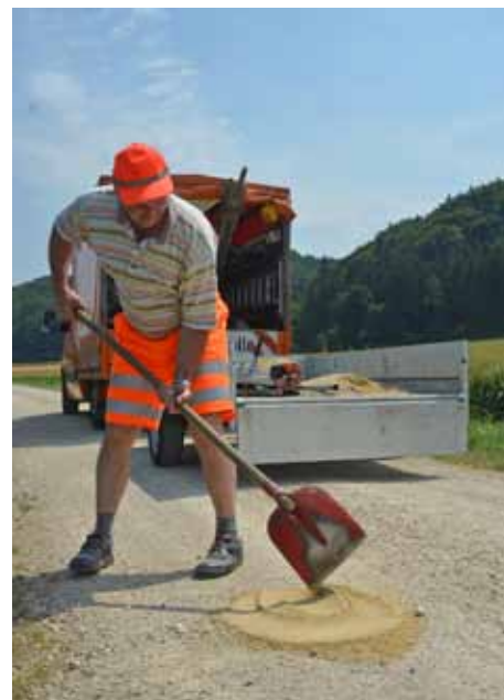
Hans Oppel hat heute die Aufgabe der Streckenkontrolle auf dem insgesamt 80 km langen Radwegenetz des Landkreises. Auch hier werden kleinere Schäden sofort beseitigt.
