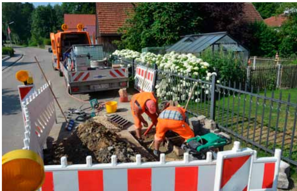
Absenkungen von Rohrleitungen und Sinkkästen sind im Donaumoos an der Tagesordnung. Kleines Bild: Jürgen Thaller (links) und Tobias Schwinger setzen den neuen Gully in den Beton.
