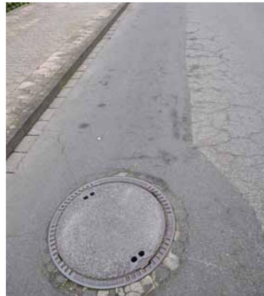
Altes Verfahren: nicht gefräst, sondern nur Asphalt darübergelegt. Dann bilden sich schnell wieder Risse in der Decke und an den Schachtdeckeln bricht das Material wieder weg.
