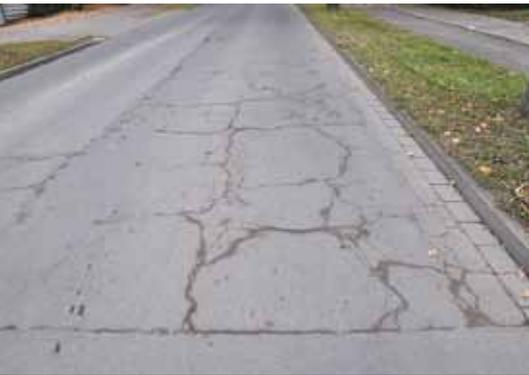
Zustand der Asphaltdecke vor und nach der Reparatur. Der Asphalt wurde ca. 4 cm tief abgefräst und mit heißem Asphalt neu gefüllt.
