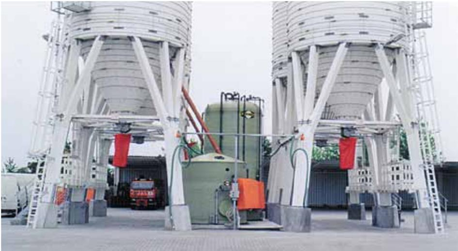
Moderne Kompaktanlage mit Salzsilos, Lösungstank und Soleerzeuger. (Bild: Stadt Leipzig)
