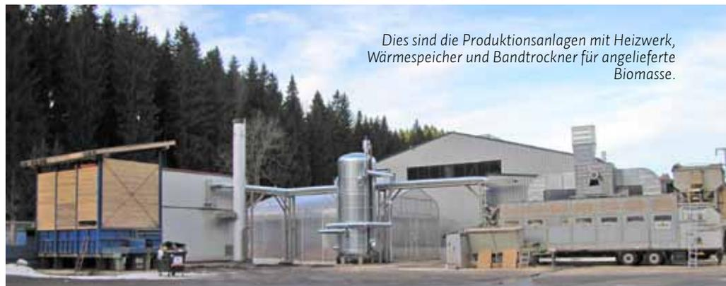
Dies sind die Produktionsanlagen mit Heizwerk, Wärmespeicher und Bandrockner für angelieferte Biomasse.
