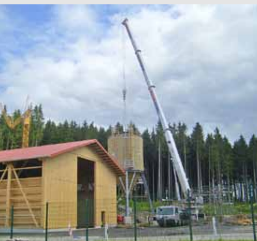
Neben der praktisch fertigen Salzhalle wird das Silo mit einem Lkw-Kran aufgestellt.
