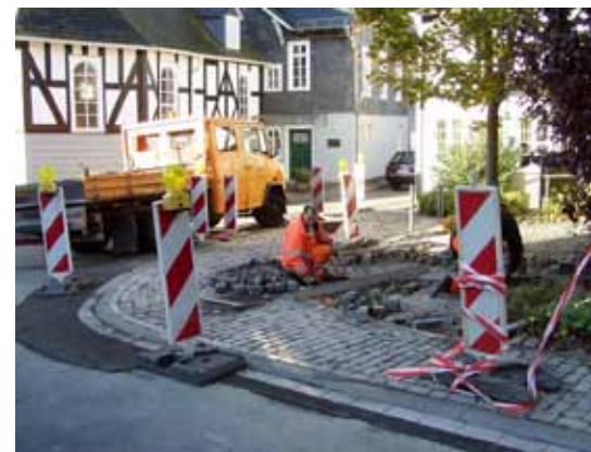
Die Aufgaben des Bauhofes Straßenunterhaltung Stadt Siegen sind vielfältig: hier wird die Außenfläche der historischen Kapellschule im Ortsteil Siegen-Eisern umgestaltet.
