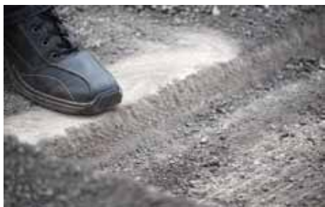
Die Asphaltfräse arbeitet auf einer stufenlos einstellbaren Tiefe zwischen 0 und 100 mm randscharf und legt das Fräsmaterial nach unten ab.
