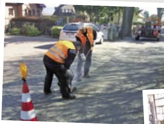
Wilfried Osterloh und Cemil Sengül reparieren mit Gussasphalt Winterschäden in den Straßen.
