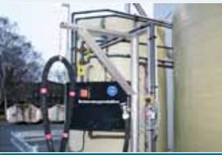
Soleerzeuger für NaCl-, MaCl-, und CaCl-Sole mit 20–22 % Sättigung ...
