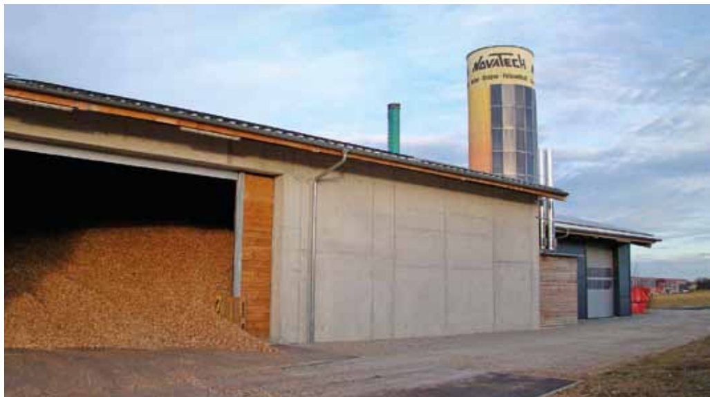
Die Hackschnitzelheizanlage versorgt Gewerbebetriebe, die Kommune und Privatleute in Wolpertshausen.
