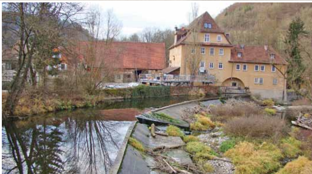
Das Wasserkraftwerk Ley liefert pro Jahr 120.000 kW Strom.
