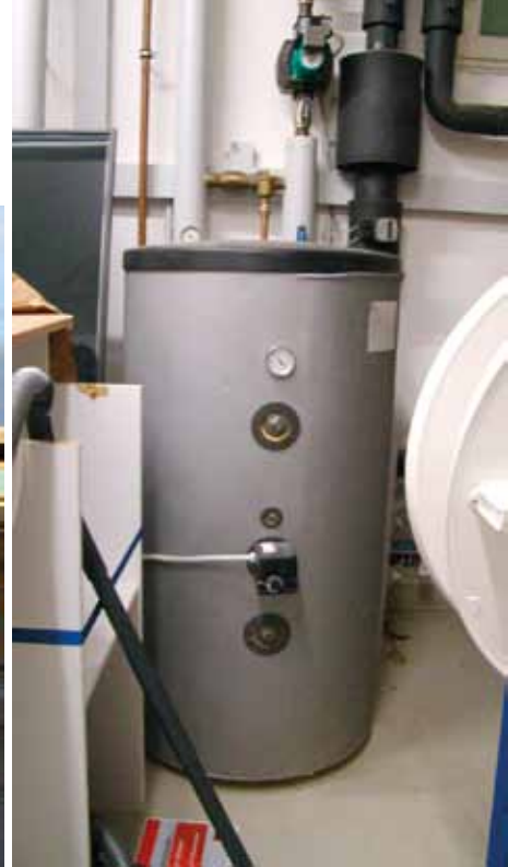
Der Europasaal wird von der Geothermieranlage mitbeheizt. Der Kessel der Anlage sieht relativ unspektakulär aus, sorgt aber für Wärme in dem 870 m 2 großen Gebäude.
