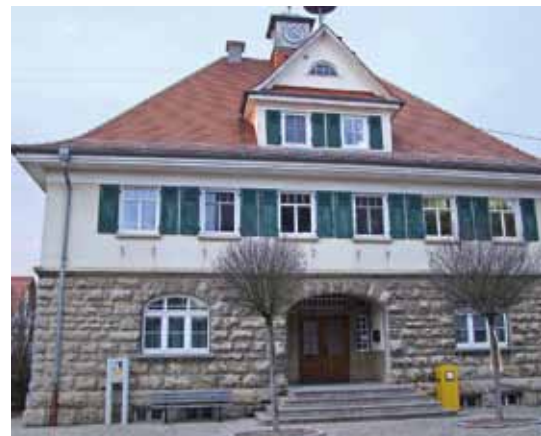
Vor dem Rathaus in Wolpertshausen steht eine E-Tankstelle für Elektrofahrzeuge.
