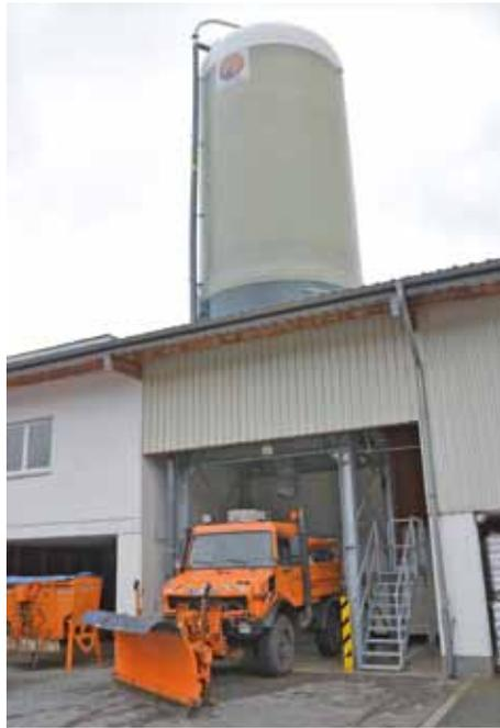
Der Füllstand des Salzsilos wird in Olsberg über vier Wägezellenmodule mit einer Nennlast von je 4 Tonnen, die unter die Stützen des Silos installiert wurden, gemessen.
