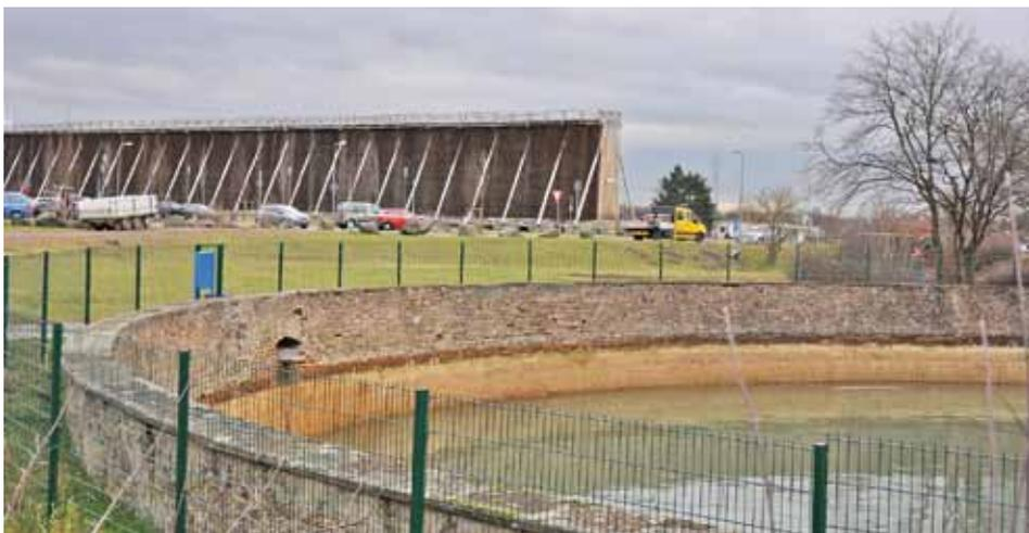
Da die Sole nur mit einem Salzgehalt von 3 % aus der Erde kommt, wird sie zunächst über die in Bad Nauheim vorhandenen Gradierbauten laufen gelassen (im Bildhintergrund). Gesammelt wird sie anschließend in einem großen Rohsolebecken am Stadtrand.
