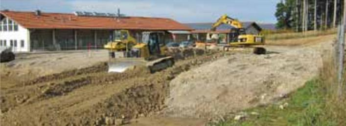
Der Aushub an der Baustelle für das neue Salzlager ist mittlerweile beendet und die Fundament-Arbeiten beginnen.
