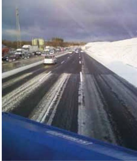
Situationsbedingte Unterschiede bei Straßenglätte zwischen OPA (vorn) und dichtem Asphalt (hinten). (Foto: Regierungspräsidium Stuttgart)
