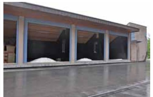
Das Streusalz wird ebenerdig angeliefert und in Silos gefüllt (oben). Die Befüllung der Streuer erfolgt ebenfalls ebenerdig ein „Bergstockwerk“ tiefer (links).
