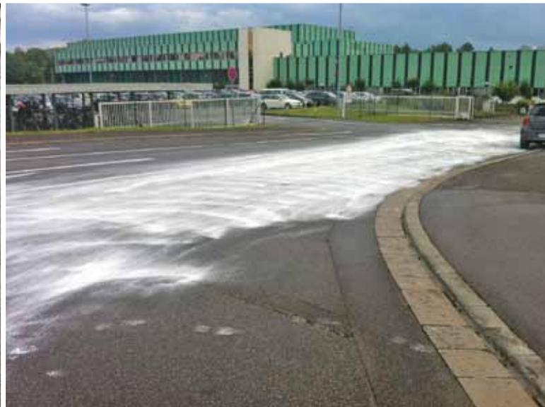
Ölbindemittel des Typs III (R) wurde großflächig aufgebracht und anschließend mit einer geeigneten Kehrmaschine wieder aufgenommen.
