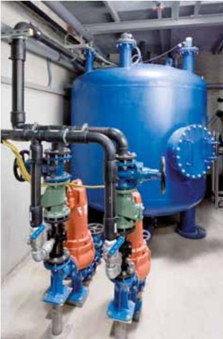
Über ein Vakuumsystem werden Küchenabfälle und Toilettenabwässer aus einigen Häusern des Neubaugebietes in Knittlingen abgesaugt.
