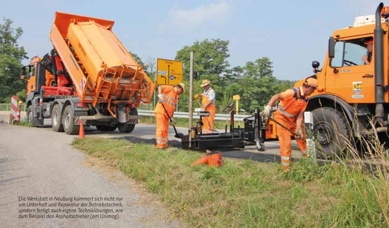
Die Werkstatt in Neuburg kümmert sich nicht nur um Unterhalt und Reparatur der Betriebstechnik, sondern fertigt auch eigene Techniklösungen, wie zum Beispiel den Asphaltschieber (am Unimog).
