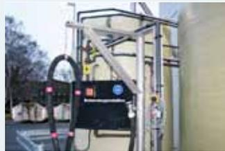
Soleerzeuger für NaCl-, MaCl-, und CaCl-Sole mit 20–22 % Sättigung ...
